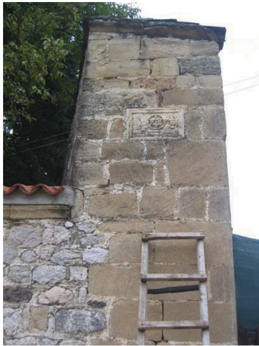
Foto 1. Die Mauer, in der die Steinplatte eingemauert wurde
